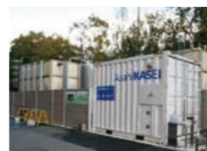
最大1時間に5000リットル供給できる井戸プラント
